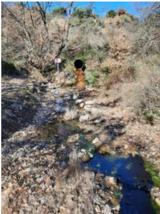
Photo 1 : Vue de la buse et des 2 fossés en provenance de la verse de l'Atelier
